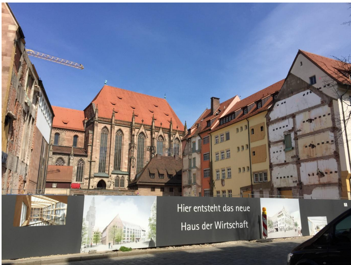
- Freier Blick auf die Sebalduskirche: Die Baustelle des „Haus der Wirtschaft“ an der Waaggasse -
