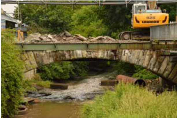
Die Landsknechtbrücke vor dem Abriss Quelle: Stadt Schwabach
