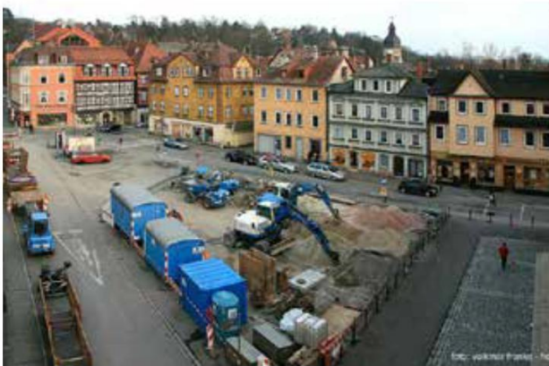
Der Albertsplatz während der Sanierung Quelle: Wohnbau Stadt Coburg
