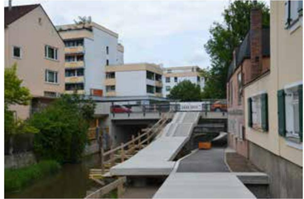
Kurz vor der Fertigstellung Quelle: Stadt Schwabach
