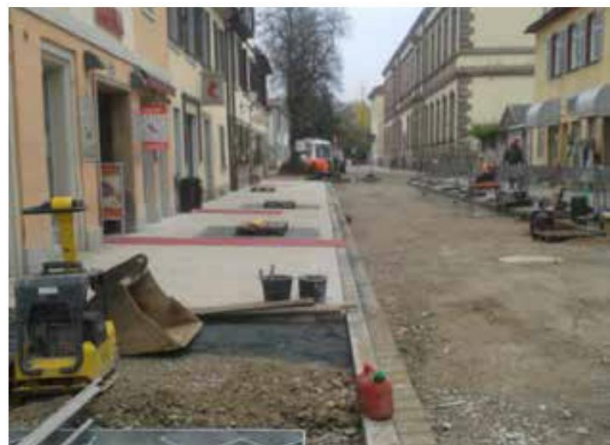
Rote Teppiche während des Umbaus Quelle: Stadt Erlangen
