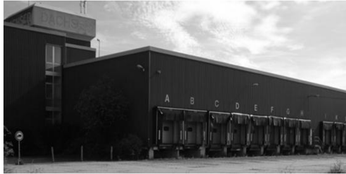
Abbildung 6: Immobilie Dachser (Hafen)
