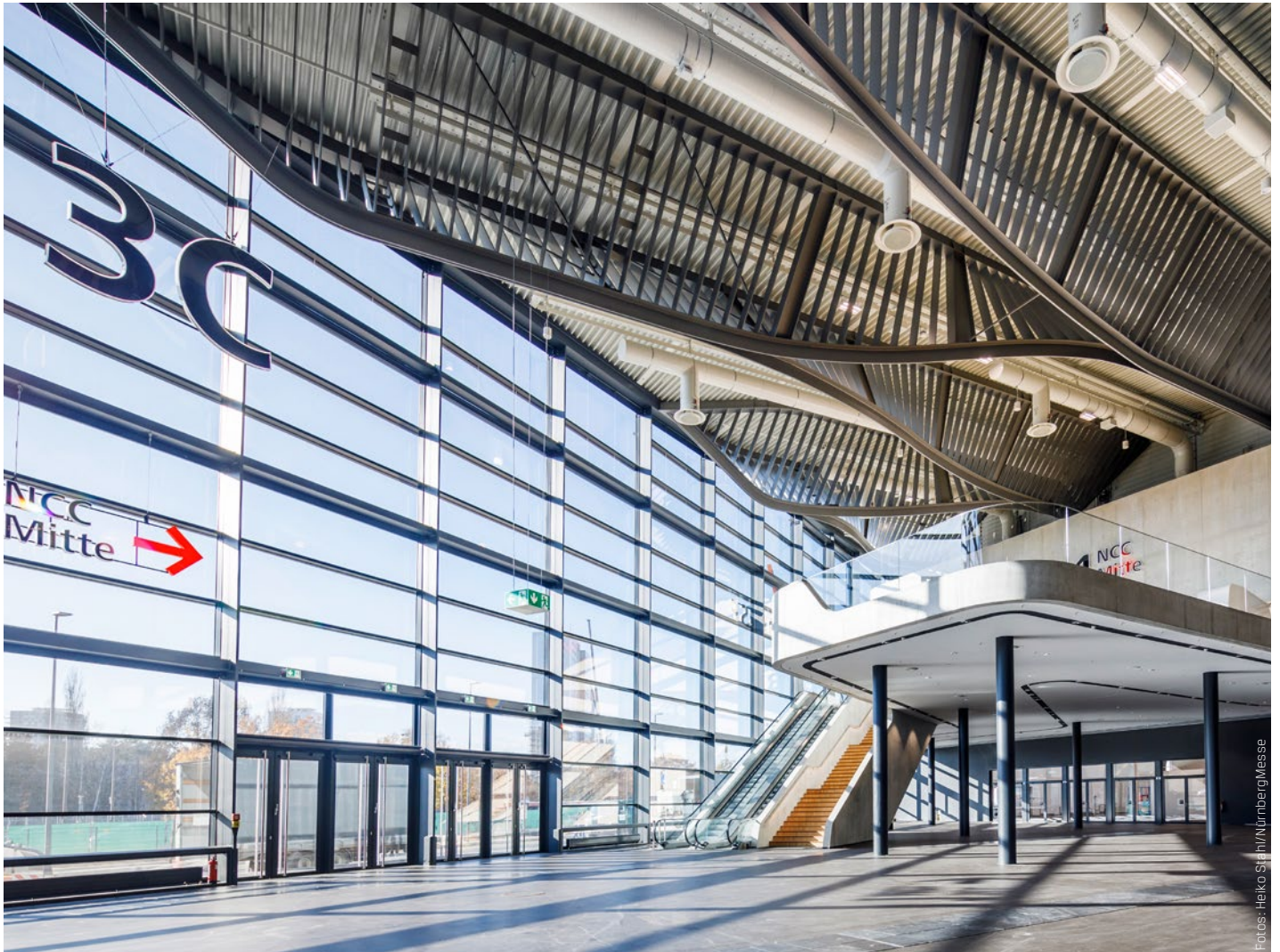
Die neue Halle 3C auf dem Messegelände.
