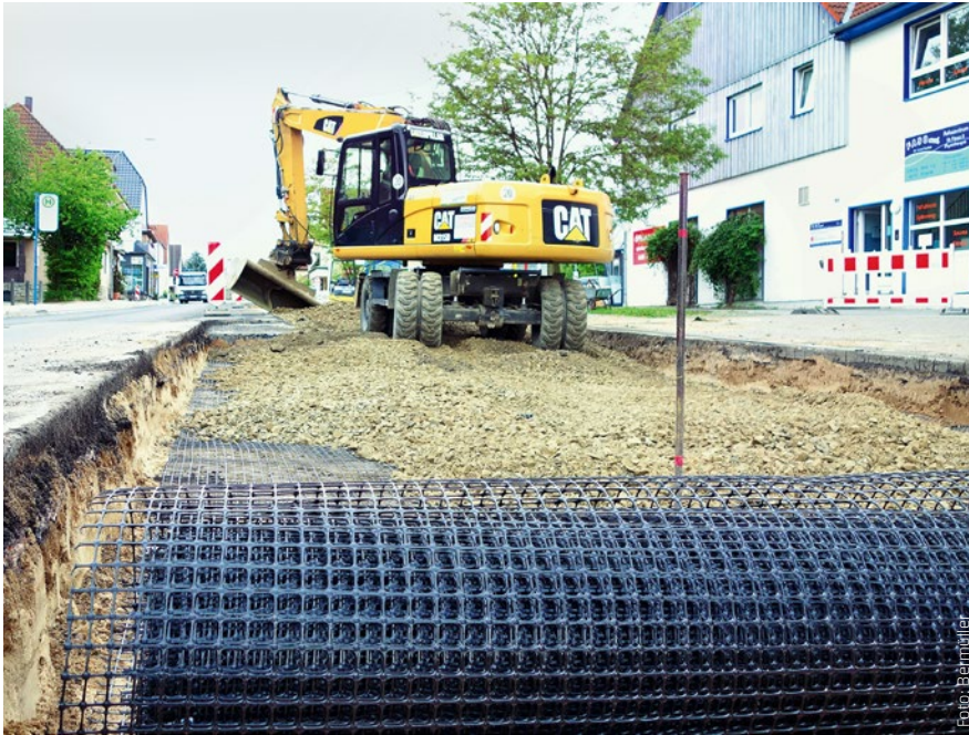
Geokunststoffe im Einsatz: Die Gitterbahnen werden im Straßenbau verlegt.
