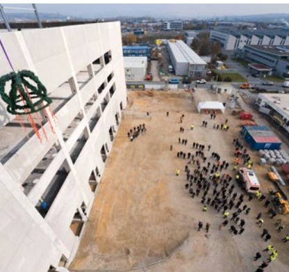
Richtfest: Das im Bau befindliche „High Energy Photonics Center“ in Forchheim.
